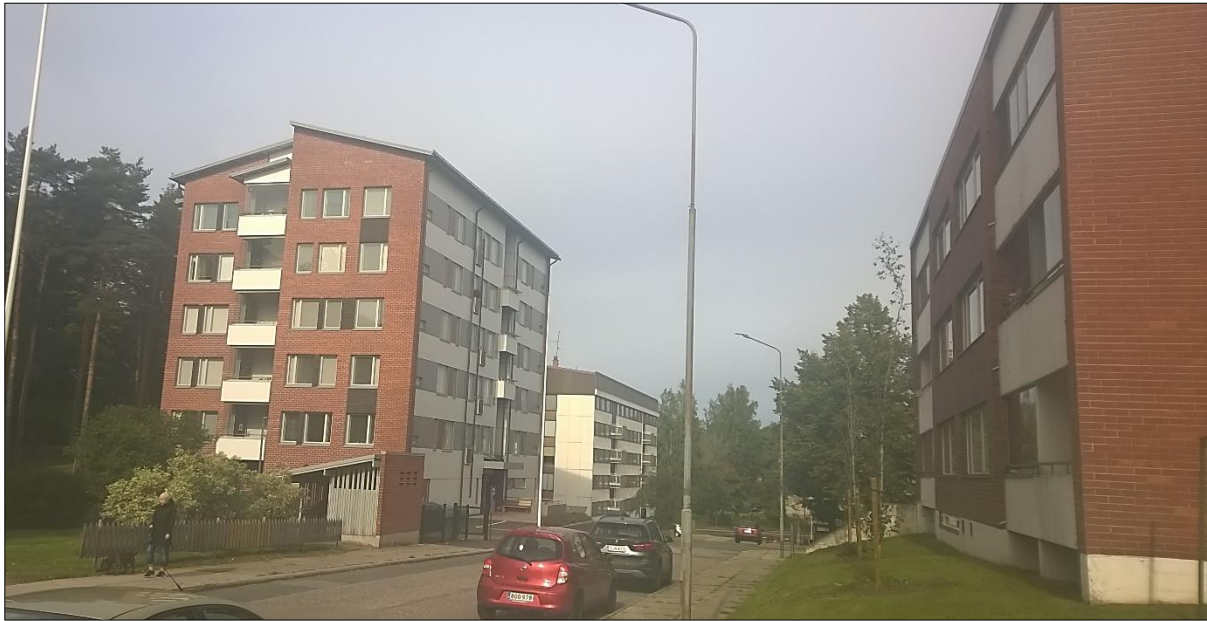
Kuva vuonna 2017 valmistuneesta kerrostalosta. Uusi rakennus on sovitettu mittakaavaltaan ja julkisivumateriaalien osalta ympäristöönsä.
