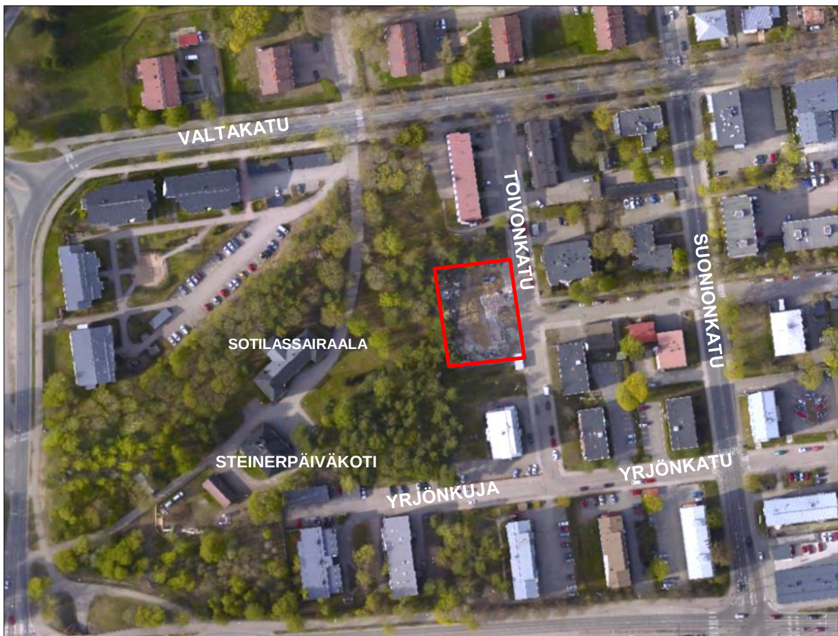
Kuva: Vuoden 2016 ortoilmakuva alueelta. Suunnittelukohde on rajattu punaisella. Vanha kerrostalo on purettu.
