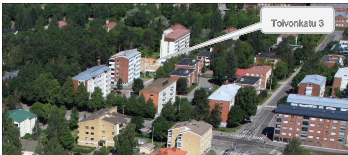
Kuva: Näkymä Leirin kaupunginosaan kesällä 2016 Helsingintien ja Suonionkadun risteys- seen. Uuden kerrostalon rakentaminen on juuri alkanut.
